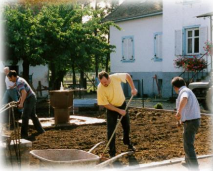
Aménagement de la fontaine et ban du millénaire
