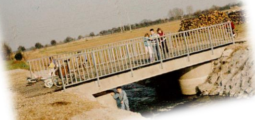
Réalisation du pont sur la scheer
