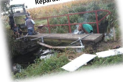
Réparation du pont Auf Rotzen
